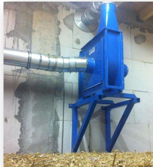
Sauggebläse Zuführung Kessel
